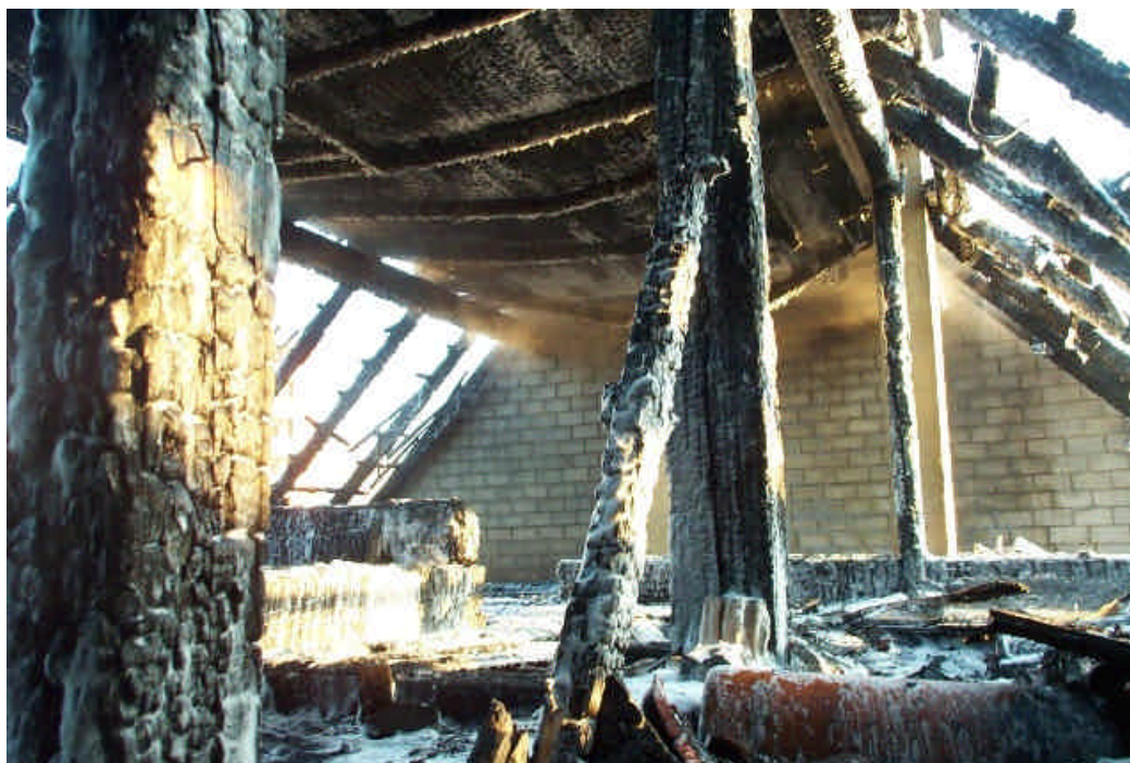
Innenansicht des ausgebrannten Dachbodens, oberhalb der Brandausbruchsstelle im DG.
