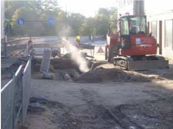
Schon aus größerer Entfernung war die Gasfontäne in der Baustelle gut sicht- und hörbar. Es bestand Explosionsgefahr im unmittelbaren Bereich.
