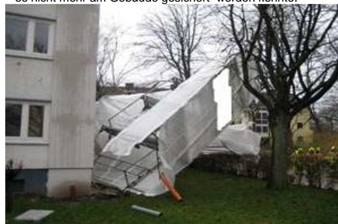
Mehrere Gerüstteile wurden demontiert um weitere Gefahrenquellen zu Beseitigen.
