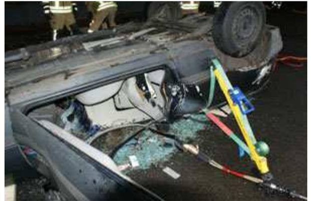
Stabilisierung mit Stab-Fast-System
