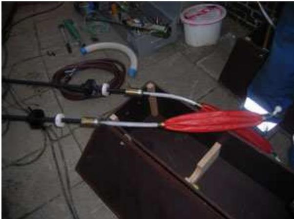
Mit je zwei dieser Spezialabsperrblasen wurde die Gaszufuhr dann vor und hinter der Schadenstelle unterbrochen.
