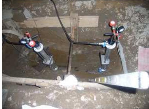
In einigem Abstand zur Schadenstelle wurden je zwei dieser Aufsätze auf die Gasleitung aufgeschweißt, durch die die Absperrblasen gesteckt wurden.
