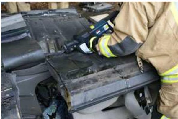
Aussägen des Bodenbleches mit der Säbelsäge
