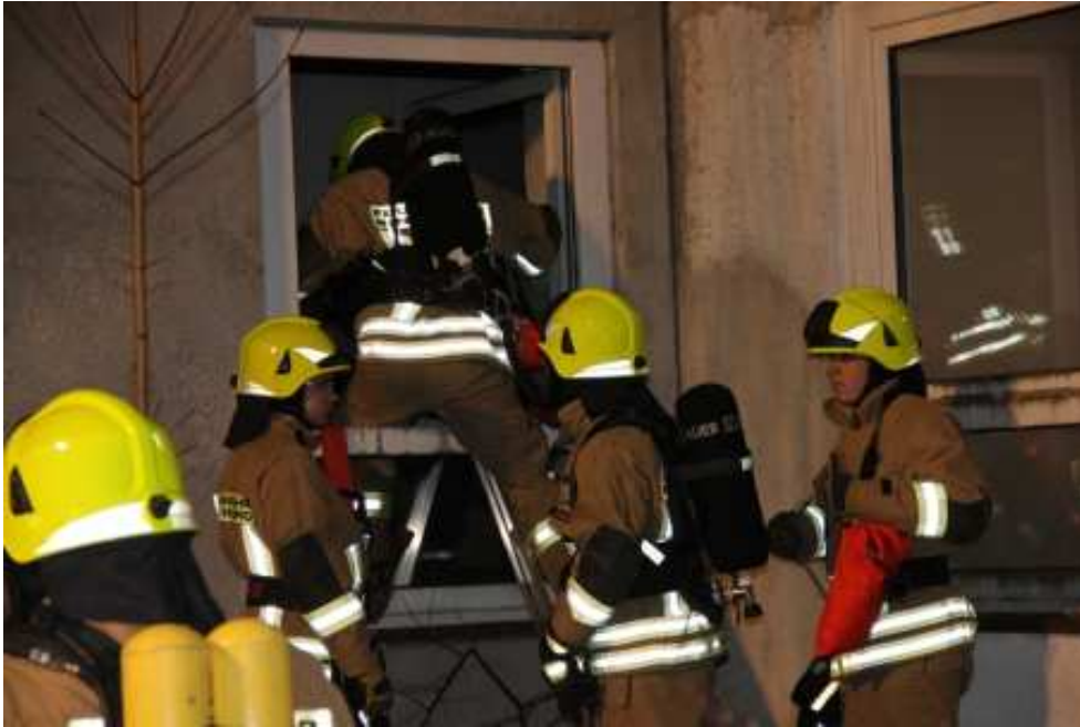
Einstieg in das Gebäude mittels Steckleiter
