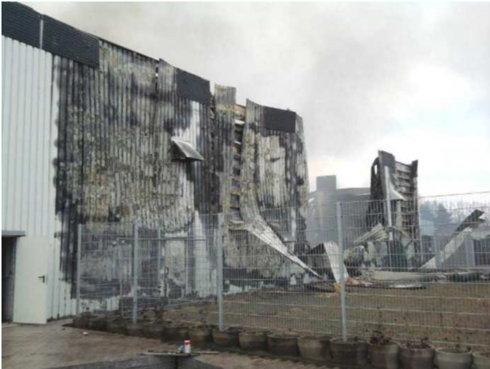
Totalschaden an der Halle
