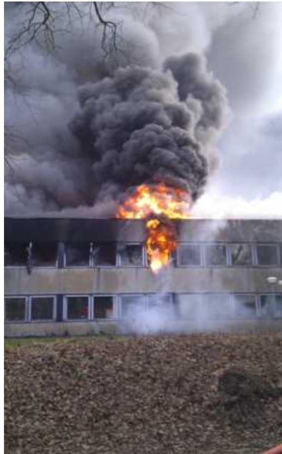
Feuer im Bürotrakt Durchzündung
