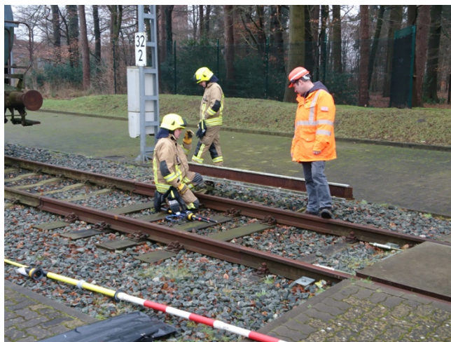
Unter Anleitung eines Mitarbeiters der Bahn wird die Erdung an einer Stromschiene der S-Bahn vorgenommen.
