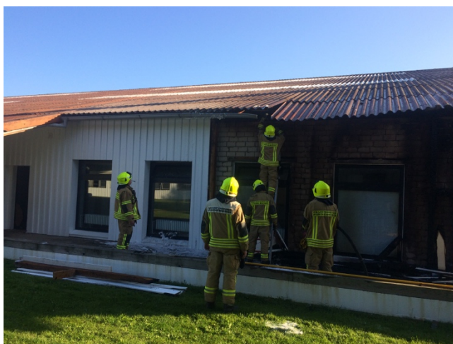
Einsatzkräfte kontrollieren die Unterkonstruktion nach Brandnestern und Glut.
